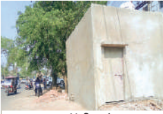
अप्सरा टॉकीज के पास निर्माणाधीन टॉयलेट ।
